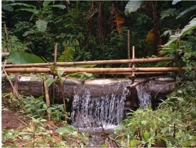
ภาพที่ 31 ฝายต้นน้ำลำธาร (Check Dam)
