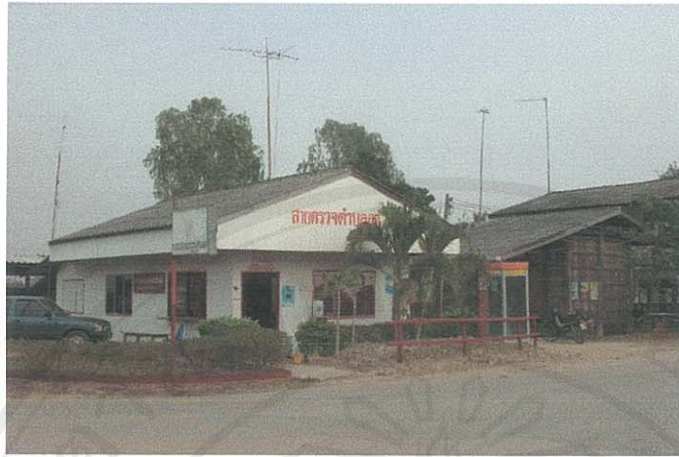
ภาพที่ 10 ป้อมตำรวจบริเวณแยกศรีเมืองชุม
