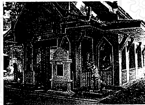
ภาพ 4 การดูแลรักษาวิหารพระสังกัจ จายน์ โดยการติดเหล็กคัตเพื่อป้องกันขโม
