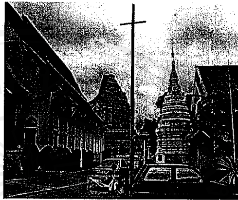
ภาพ 26 เสาไฟฟ้าที่ไร้สายซึ่งขัดต่อภาพ ลักษณ์ของโบราณสถาน
