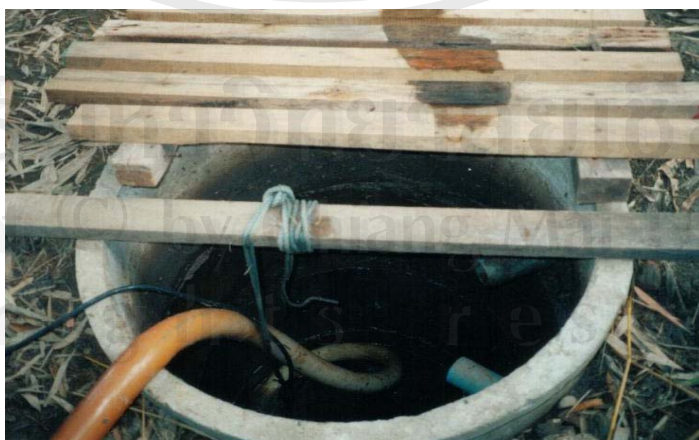
การระบายน้ำเสียออกจากบ่อตกตะกอนโดยใช้สูบน้ำ
