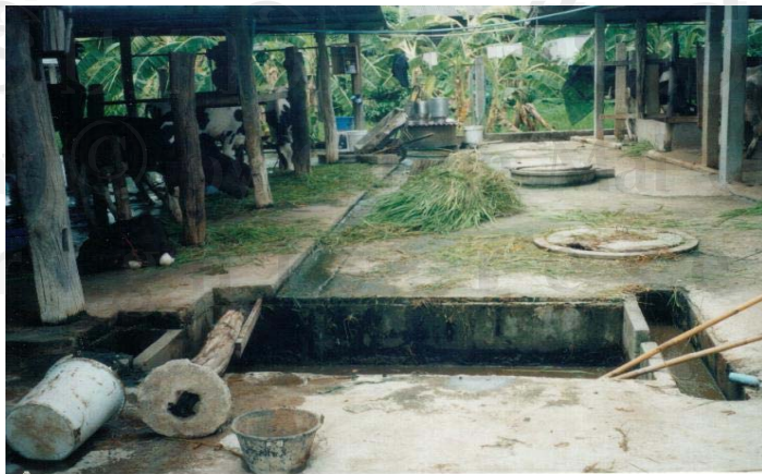
รูปแบบการนำน้ำเสียไปทำบ่อก๊าซชีวภาพ
