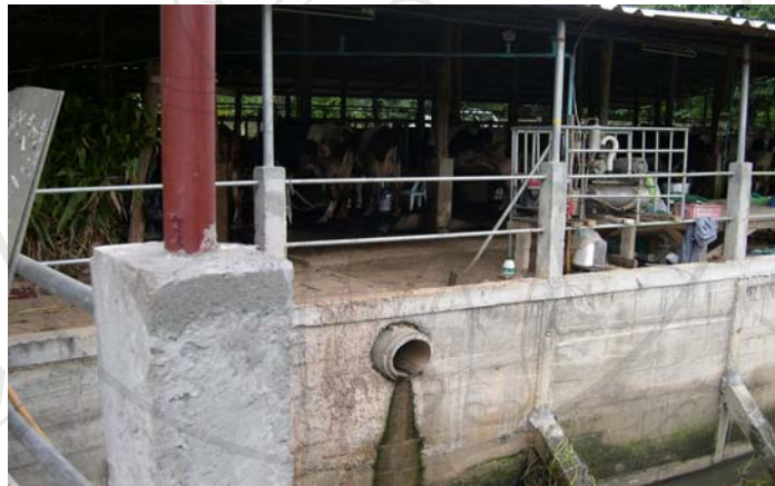
รูปแบบการระบายของเสียลงลำน้ำแม่อน โดยการต่อท่อและไม่ผ่านการบำบัด
