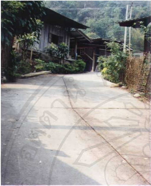
ถนนคอนกรีตในซอยที่ลาดชัน แต่สะอาด
