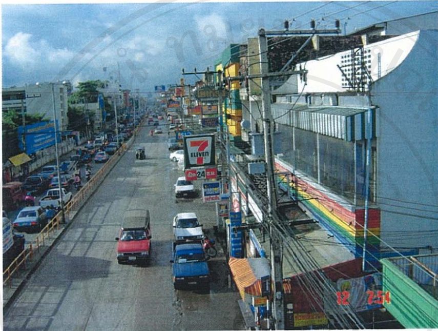
ภาพที่ 1 สายไฟฟ้าและสายโทรศัพท์ที่ระโยงระยางไม่เป็นระเบียบ
