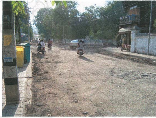
ฝุ่นละอองจากการก่อสร้าง ถนนราชดำเนิน
