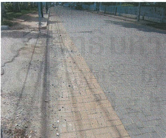
เศษดินที่ไม่เรียบร้อยจากการก่อสร้าง
