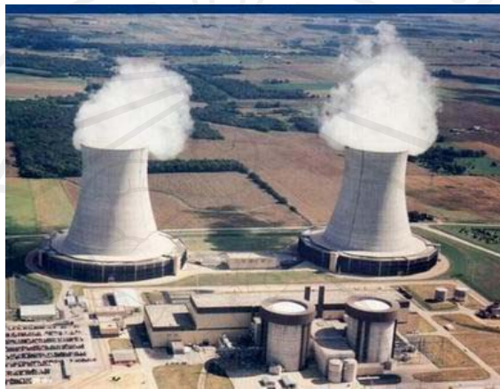
รูปที่ 3.3 โรงไฟฟ้าพลังงานนิวเคลียร์
