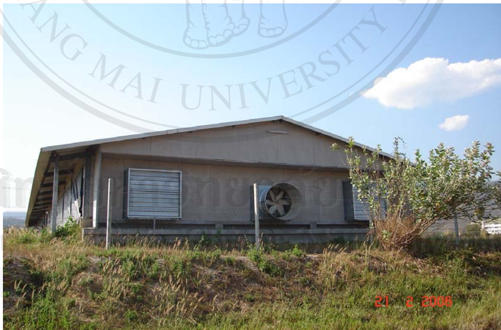
รูปที่ 3.6 โครงสร้างโรงเรือนพร้อมอุปกรณ์ในการติดตั้งเล้า Evap (b)
