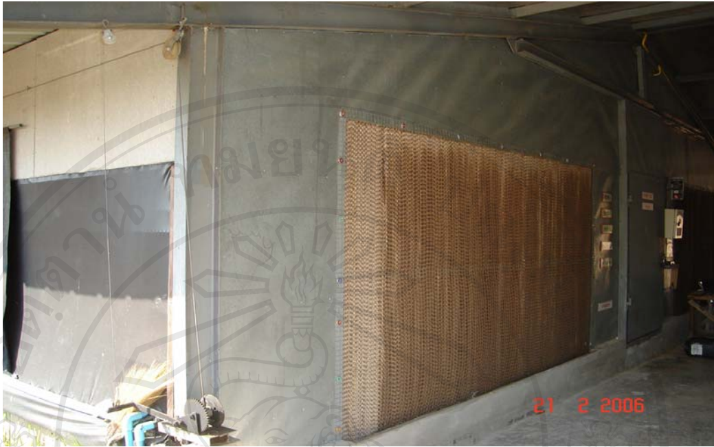
รูปที่ 3.3 การใช้ก้อน Cooling Pad เพื่อให้ความเย็นภายในโรงเรียน
