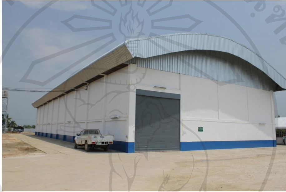
ภาพที่ 4.4 อาคารผลิตที่มองจากภายนอก
