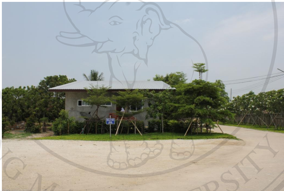
ภาพที่ 4.27 อาคารสำนักงาน
