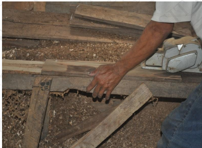
ภาพที่ 48 ขัดผิวไม้ด้วยเต่าขัดผิวไม้ (เต่าไฟฟ้า)
