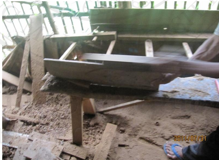
ภาพที่ 14 ไซขอบแผ่นไม้สักเก่าให้เรียบโดยใช้เต้าขัดผิวไม้(เต้ามือ)
