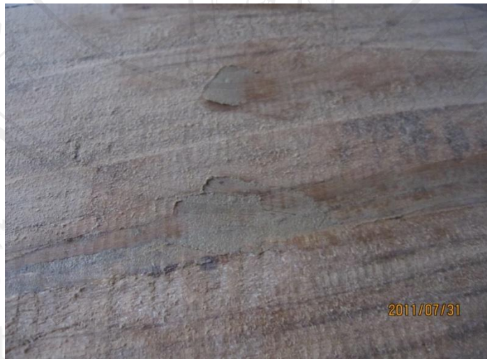
ภาพที่ 24 ปิดรอยแม็กซ์ด้วยขี้เลื่อยอ่อนผสมกาวลาเท็กซ์
