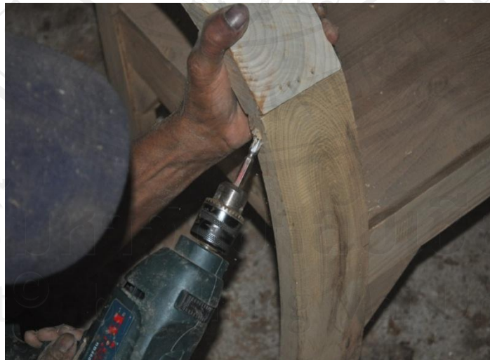
ภาพที่ 59 ใช้สว่านเจาะนำศูนย์และสว่านอัดสกรูเกลียวปล่อยยึดชิ้นงาน
