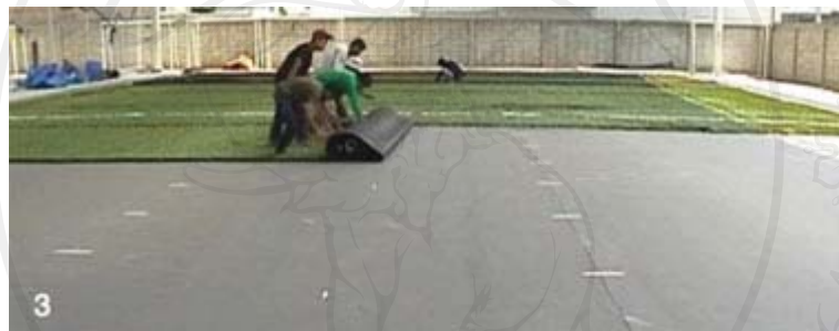
3.3 นำพรมหญ้าเทียมปูให้ทั่วทั้งสนาม ให้ขอบของพรมหญ้าเทียมแต่ละผืนชิดกันพอดีโดยไม่เกยทับกัน และดึงให้เรียบตึง ไม่มีรอยย่น
