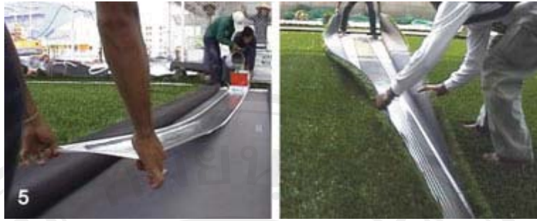
3.5 ใช้กาวปิดลงบนผ้าสังเคราะห์ เพื่อเชื่อมต่อระหว่างพรมหญ้าเทียม
