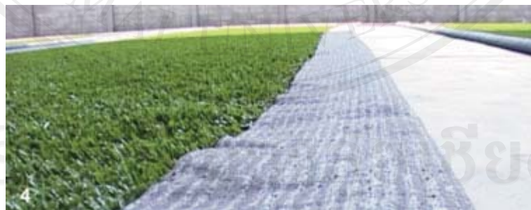
3.4 พับริมขอบของพรมหญ้าเทียมแต่ละผืนขึ้นมา เพื่อเว้นช่องระหว่างพรมหญ้าเทียมแต่ละผืน
