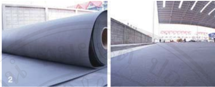
3.2 ใช้ผ้าสังเคราะห์ Geo Textile ปูรองพื้นสนามเป็นชั้นแรก
