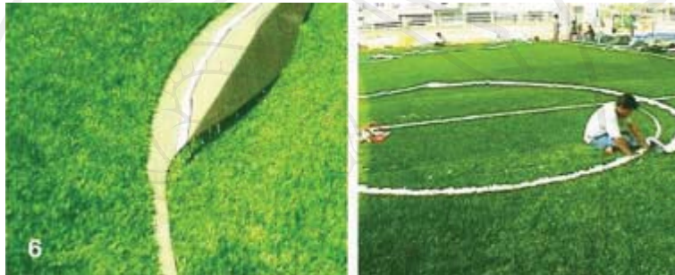
3.5 ใช้กาวปิดลงบนผ้าสังเคราะห์ เพื่อเชื่อมต่อระหว่างพรมหญ้าเทียม
